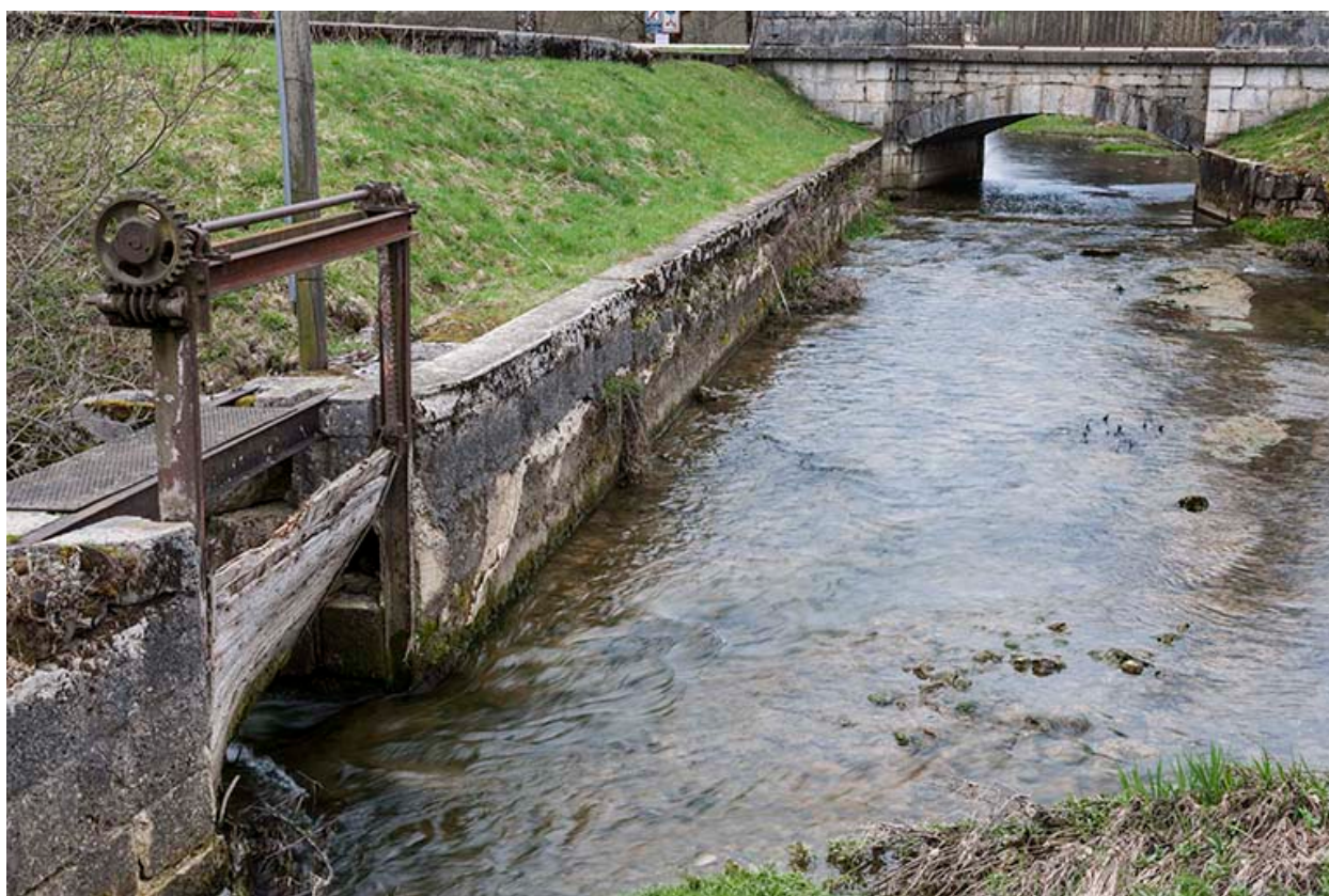
Canal d'amenée et vanne de décharge.
