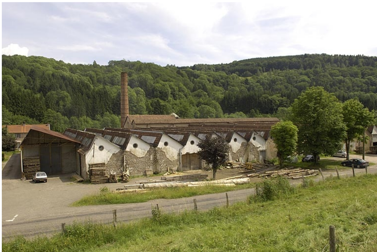
Vue plongeante sur les ateliers de fabrication.
