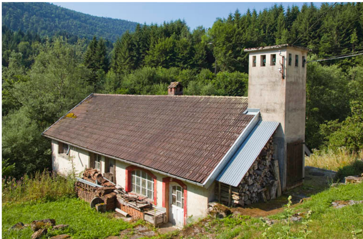
Scierie Renaud puis centrale hydroélectrique Huot-Marchand, Battenans-Varin.
