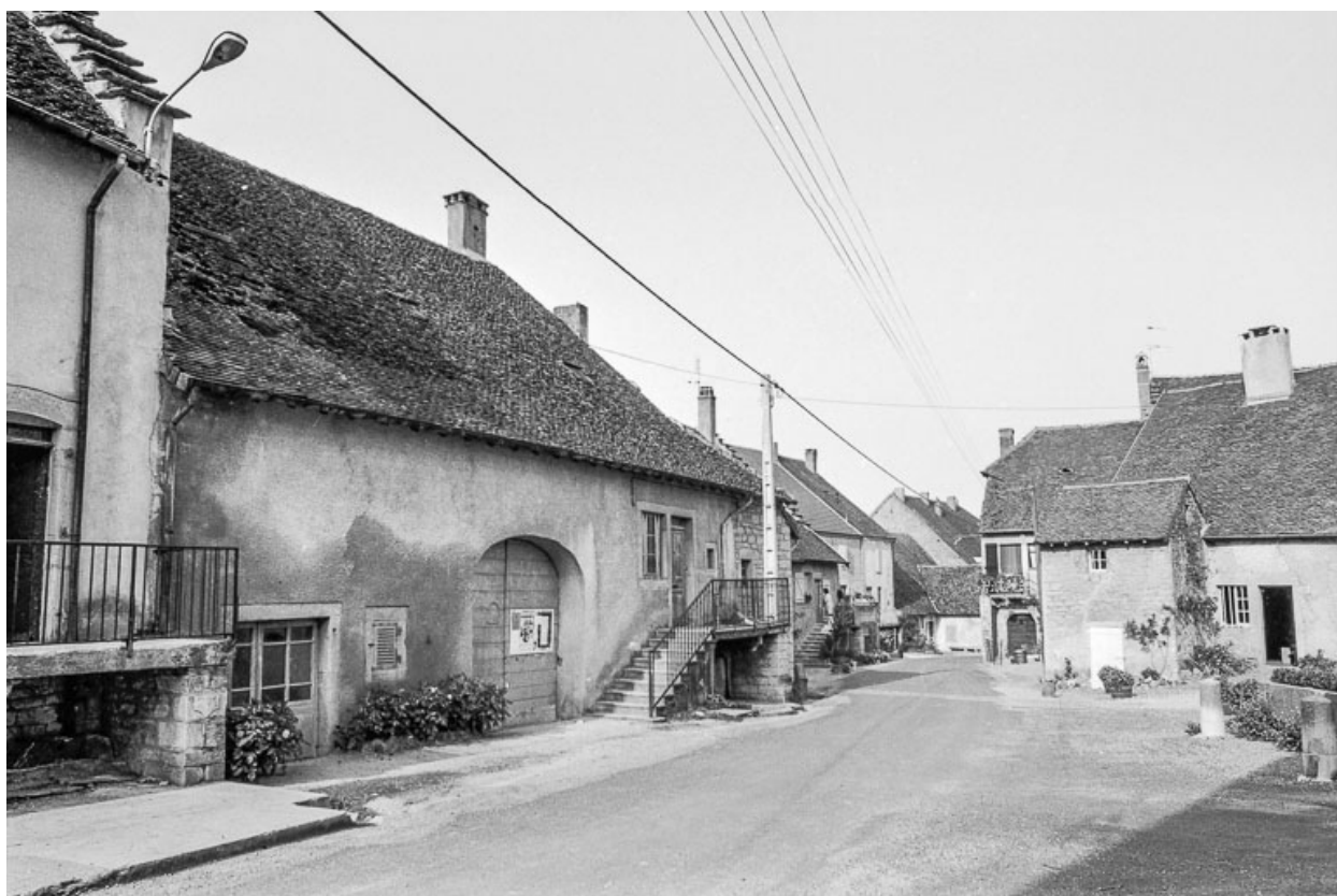
Vue générale de la rue principale.
