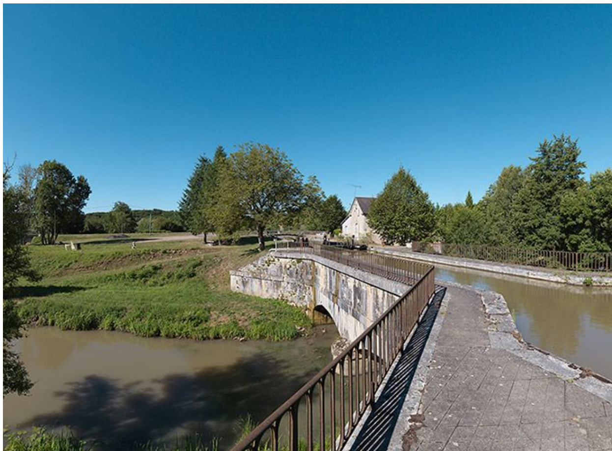
Le pont canal de Mingot à Châtillon-en-Bazois.
