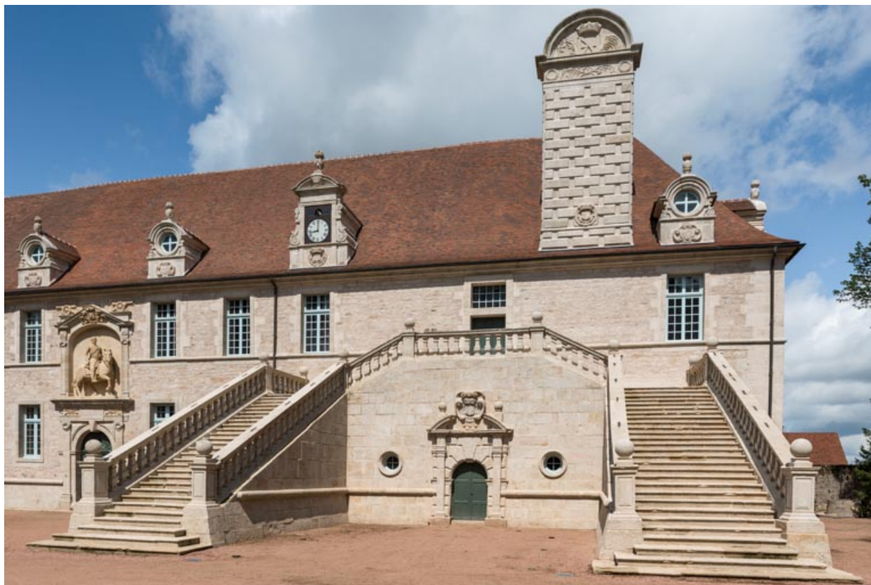
Façade sud-est, partie droite, grand-degré.
