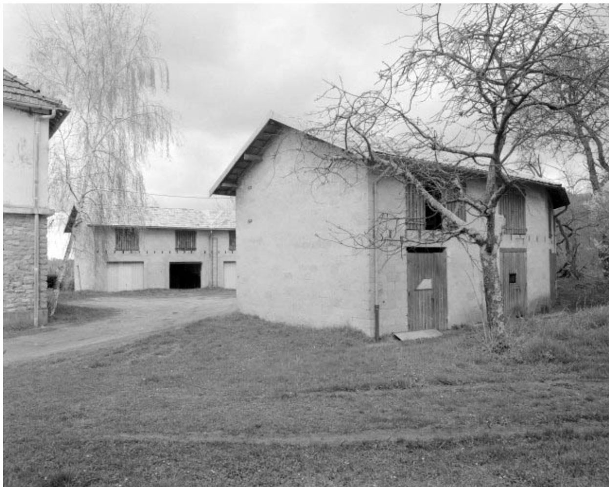
Remise d'automobile et bûcher (F) : vue d'ensemble.
