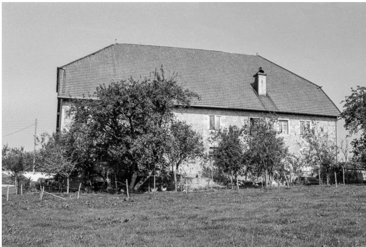
Ferme cadastrée 1961 AB 42 : vue d'ensemble.
