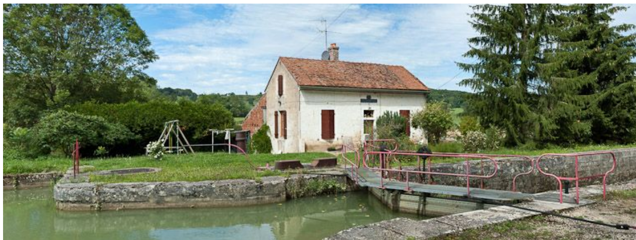
Vue d'ensemble du site d'écluse.
