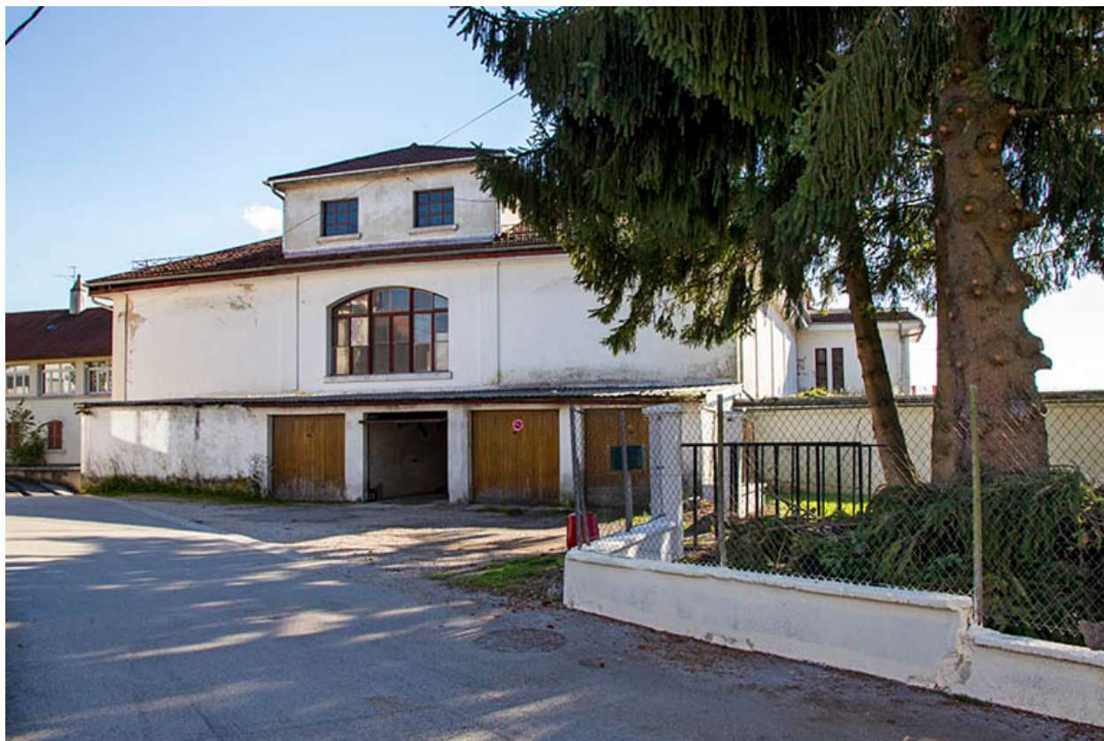
Bâtiment nord : façade latérale droite.
