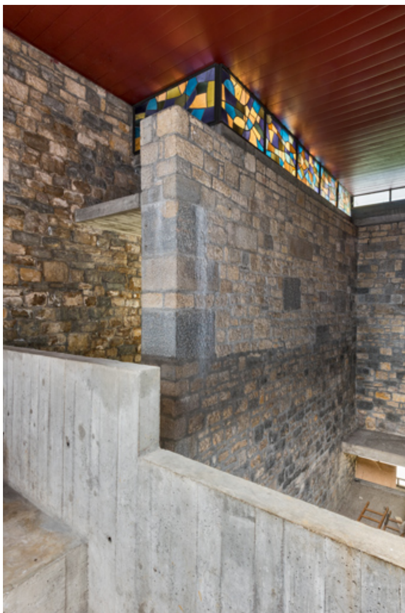
Verrière horizontale du mur sud. Vue de trois quarts.
