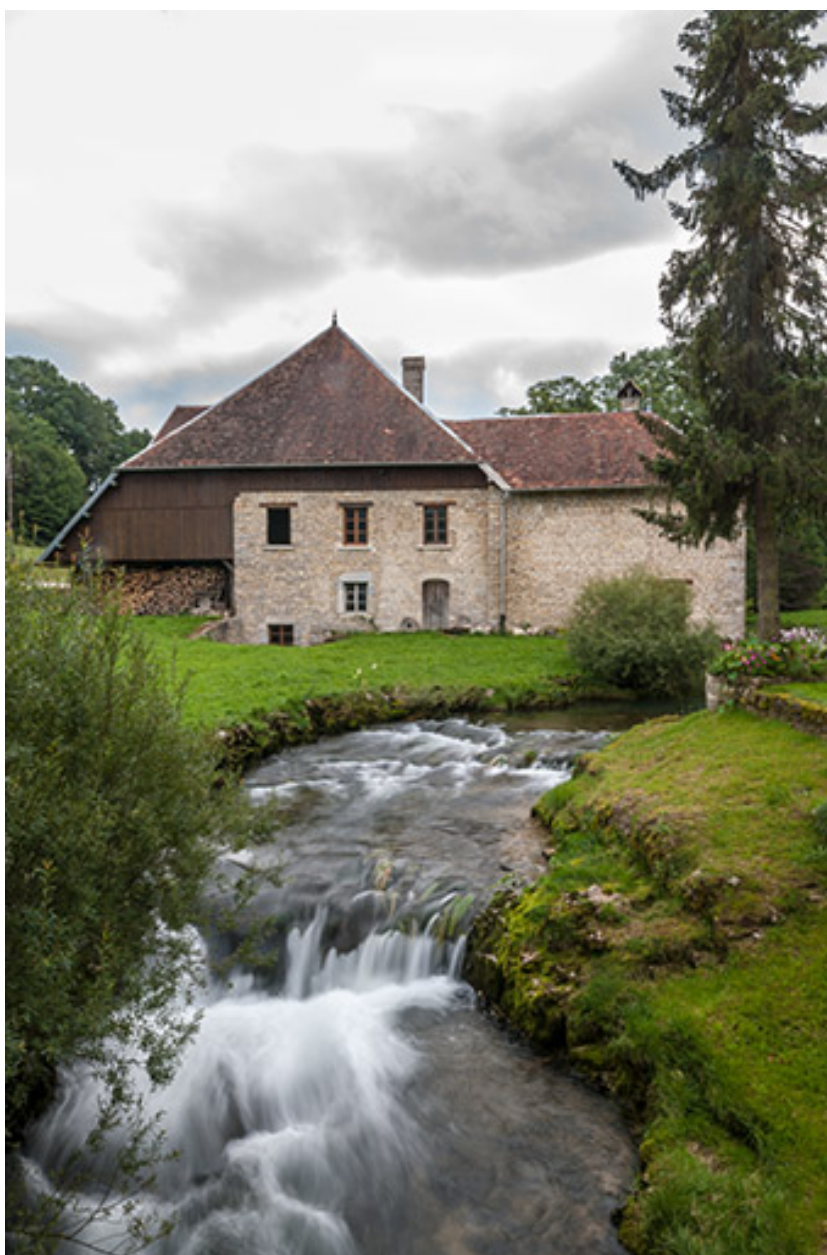
Vue d'ensemble depuis le nord-ouest (cadrage vertical).
