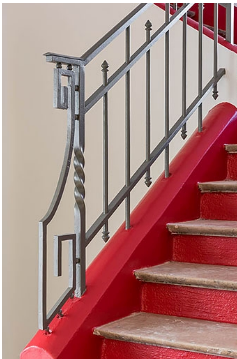
Vestibule : grille de l'escalier.
