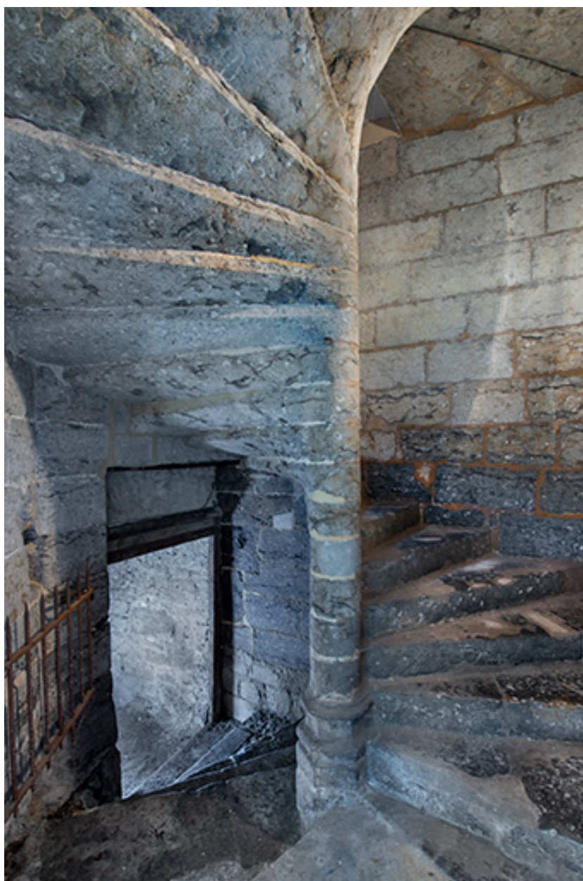
Escalier en vis : départ de la cave.
