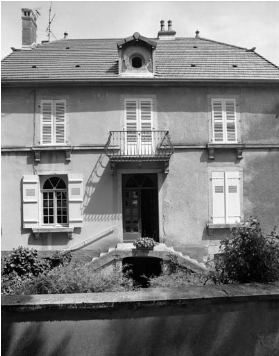
Façade antérieure, de face.
