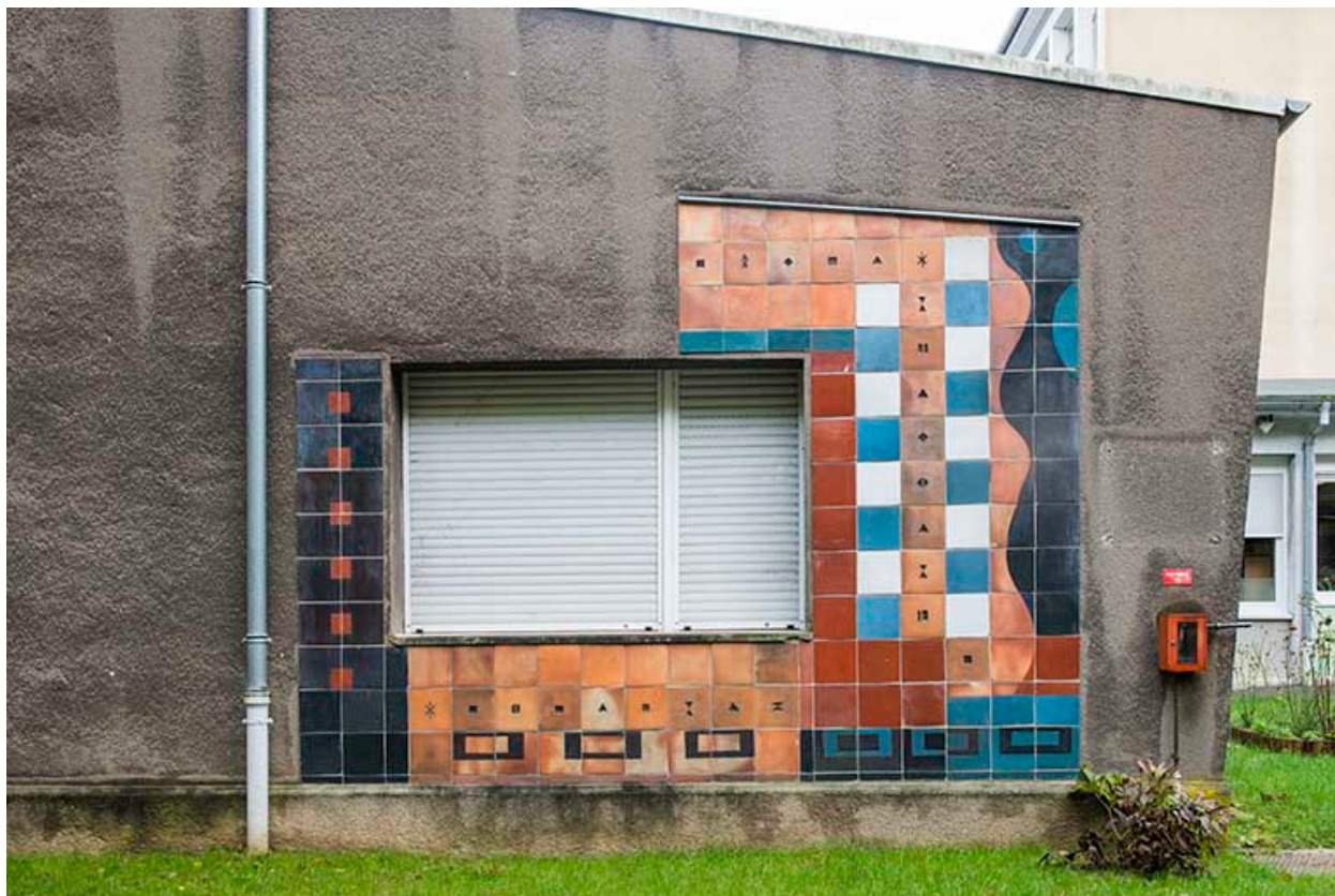
Oeuvre de Bizette. Façade sur rue.
