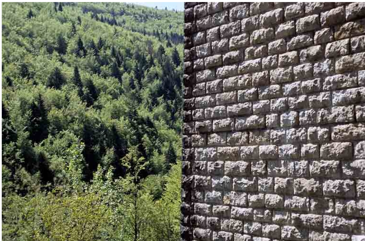
Viaduc du Puits : parement d'une pile.
