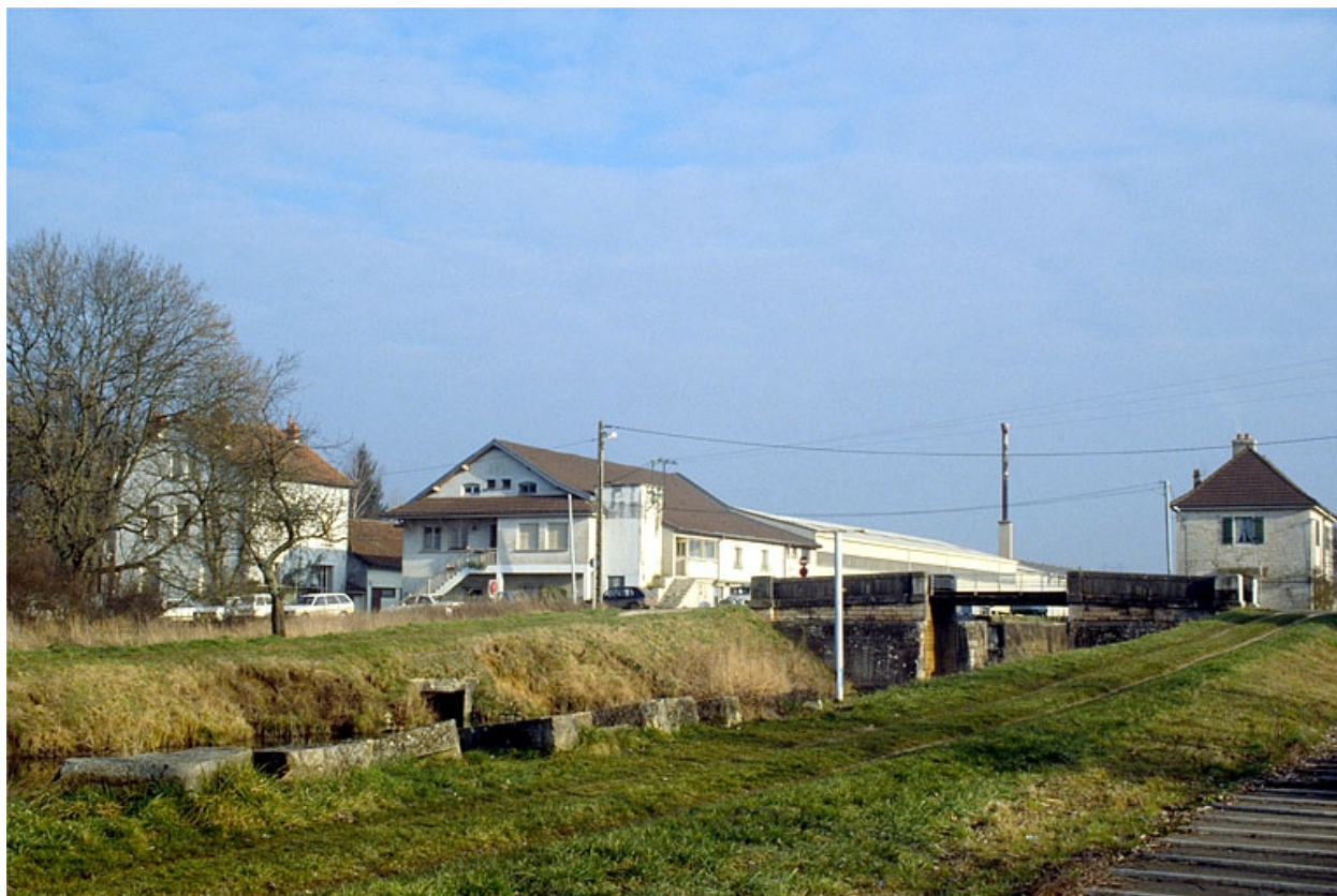
Vue d'ensemble depuis l'ouest.
