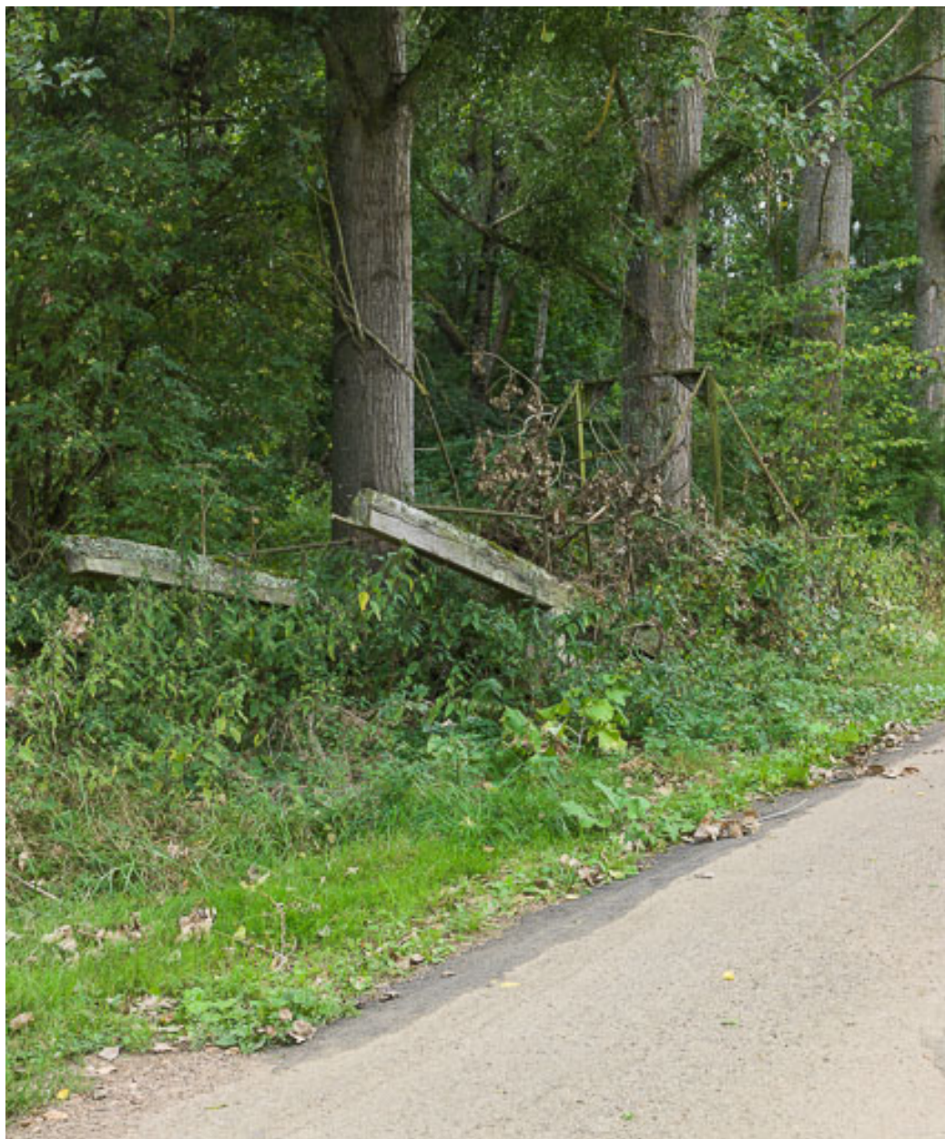
Ancienne passerelle abandonnée.
