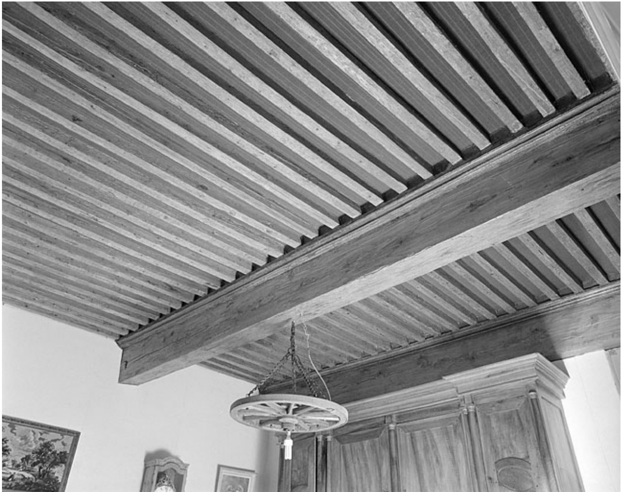
Plafond d'une pièce de l'étage.
