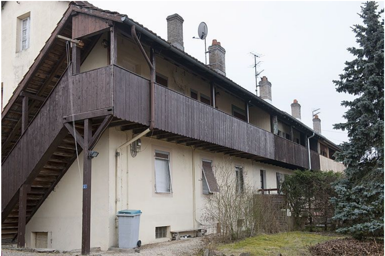
Immeuble (12 logements ?). Façade postérieure.
