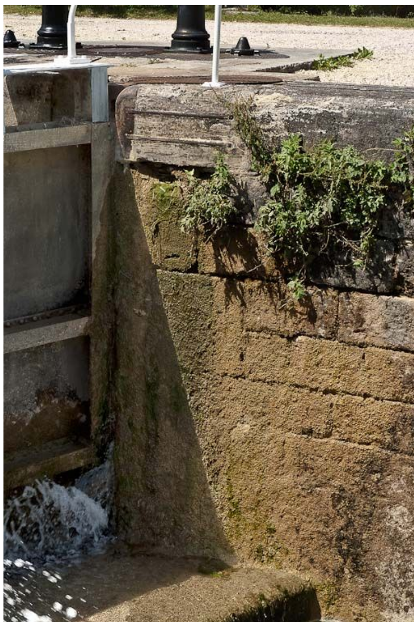
Détail de la maçonnerie du sas d'écluse.
