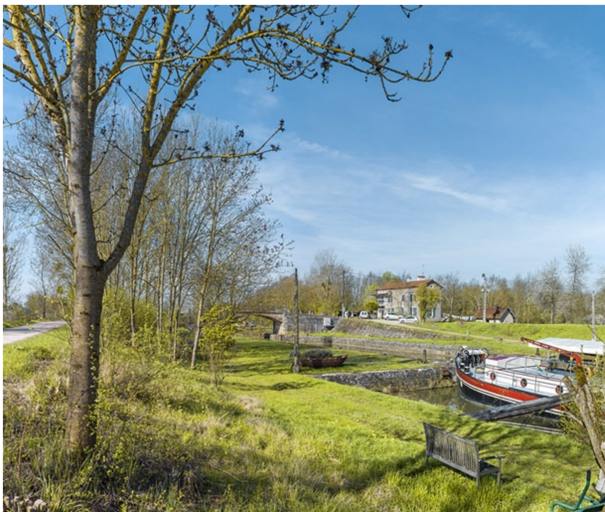
Le site d'écluse depuis le port.
