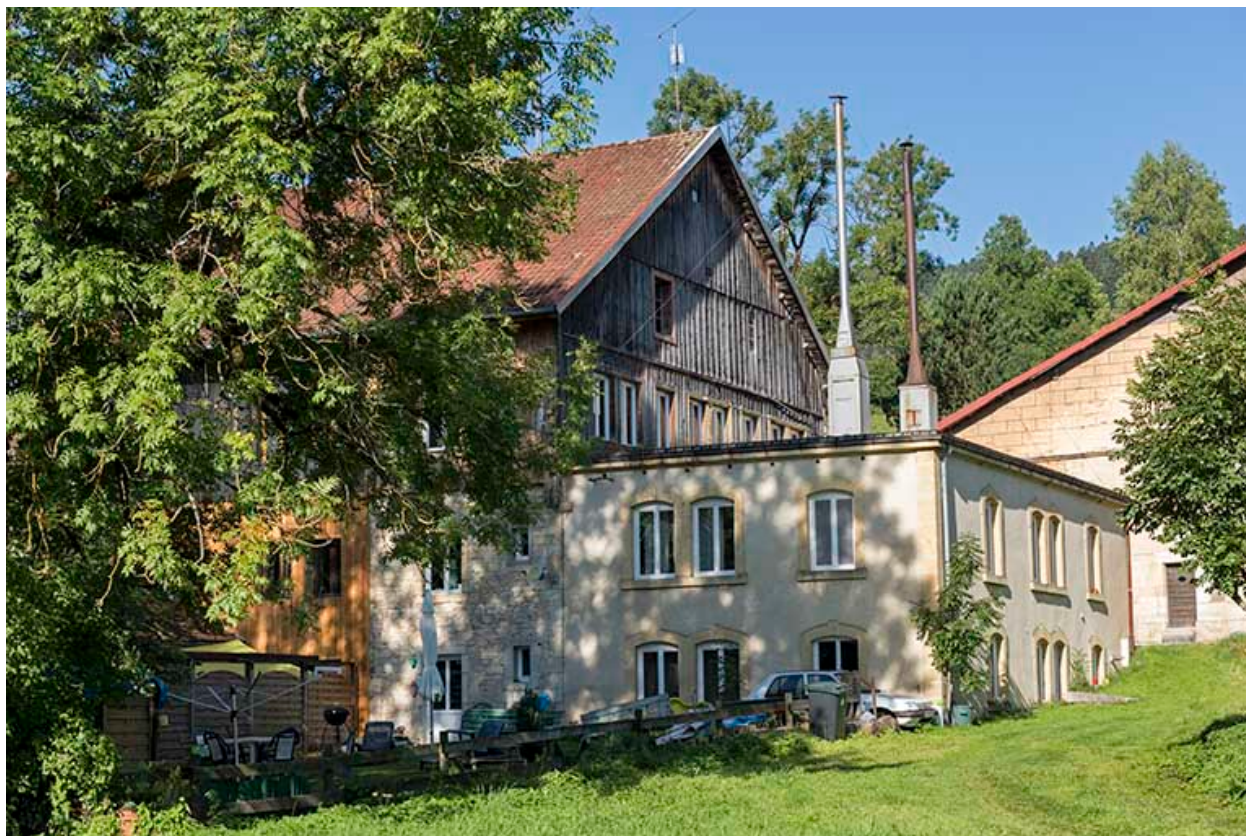
Extension nord, vue de l'est.
