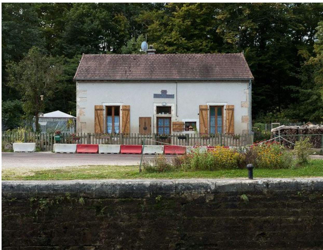
Vue de face de la maison éclusière.
