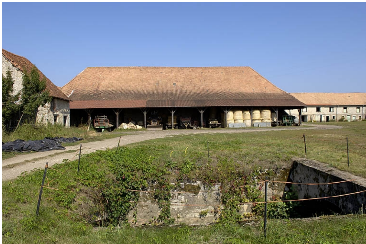
Halle à charbon vue depuis le sud.
