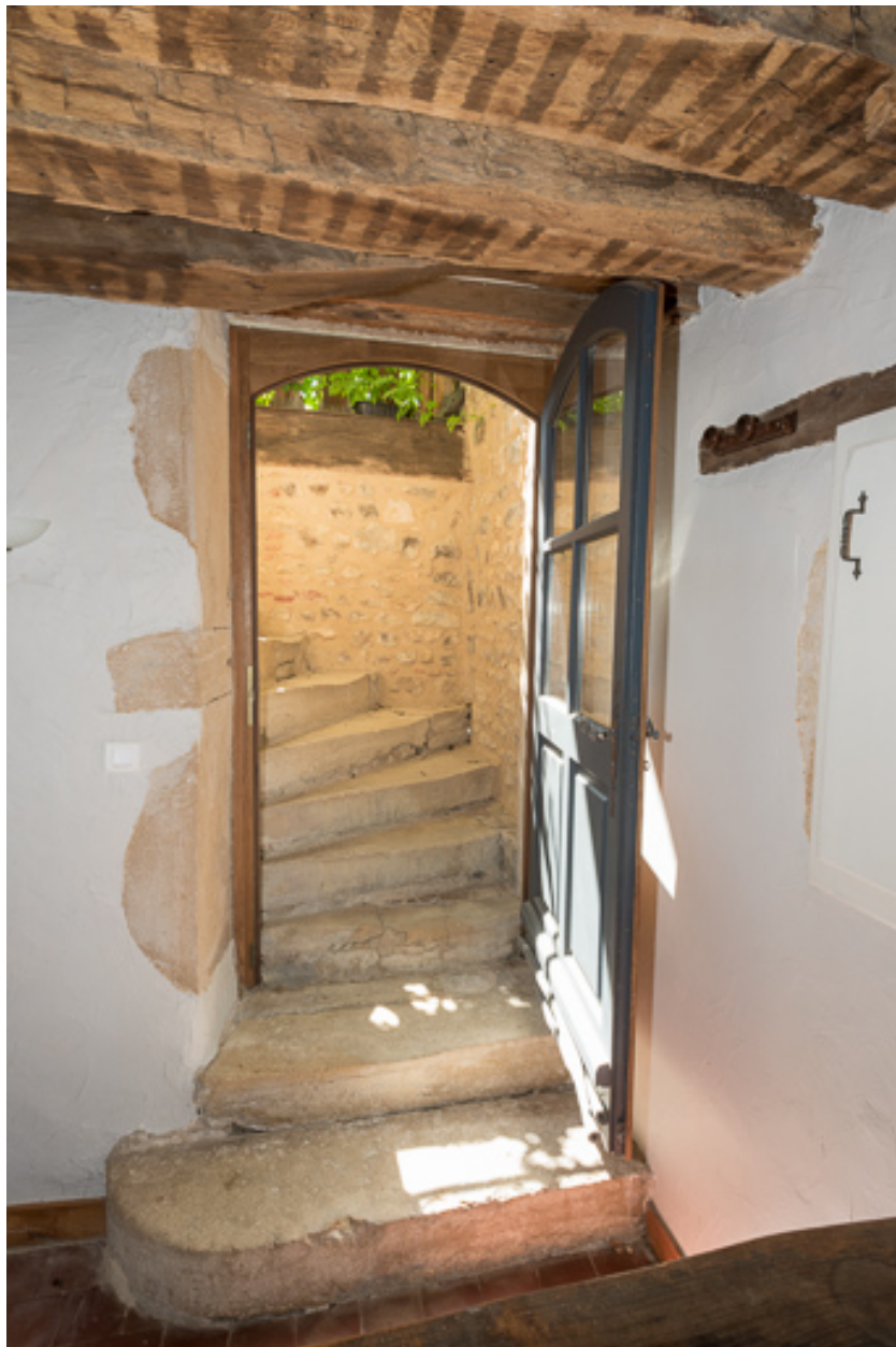
Escalier donnant accès à la galerie
