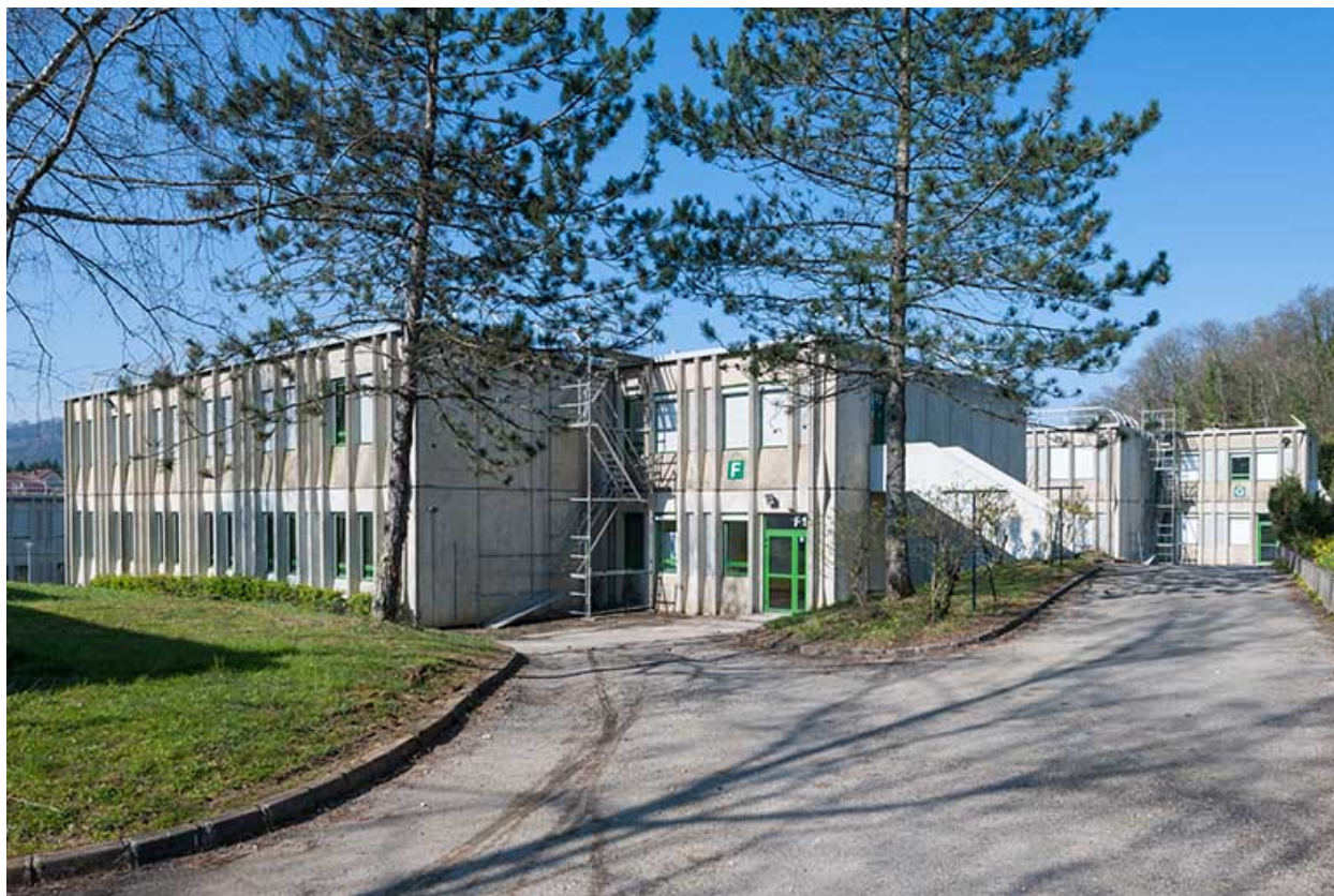
Entrée du lycée.
