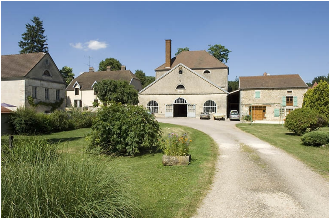
Vue d'ensemble depuis l'entrée, au sud.
