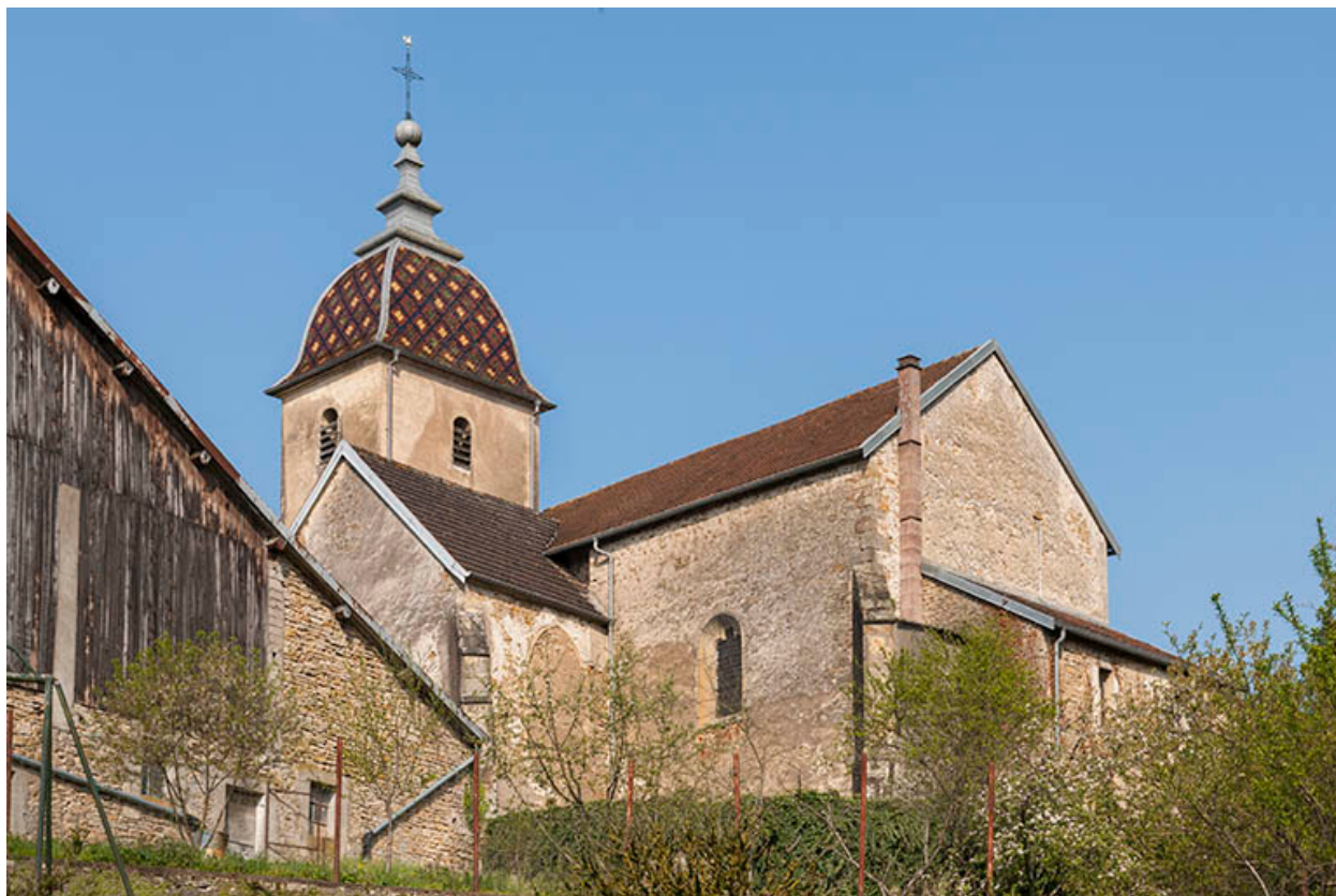
Vue depuis le sud-est.
