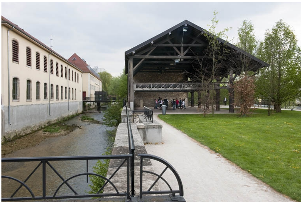
Ateliers de filature et hangar à bois.
