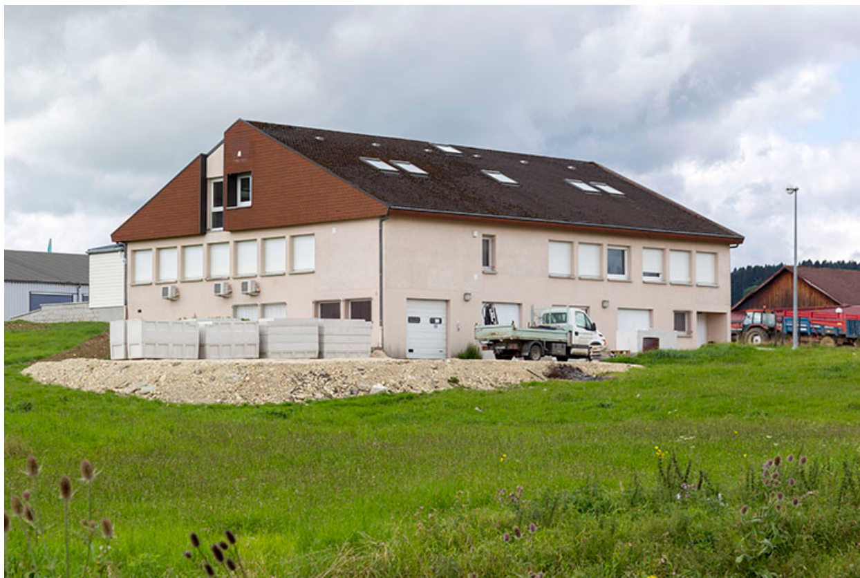
Façades postérieure et latérale droite.
