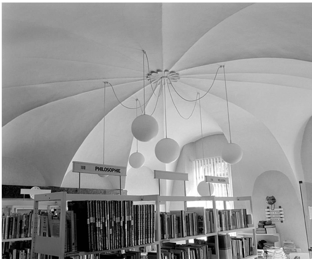
Bâtiments conventuels, voûte de l'ancienne cuisine.
