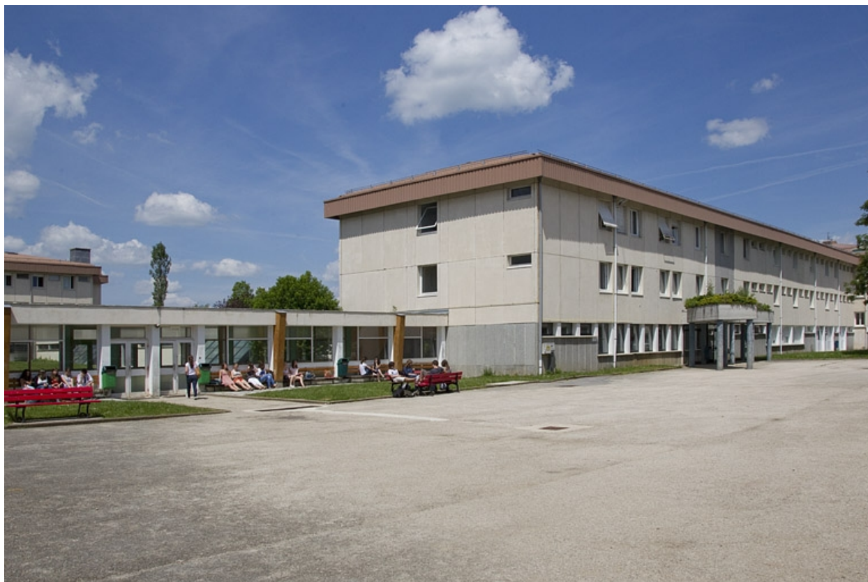
Galerie et bâtiment de l'infirmerie.
