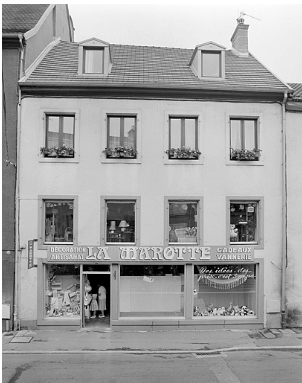
Façade sur la rue de la Schliffe.
