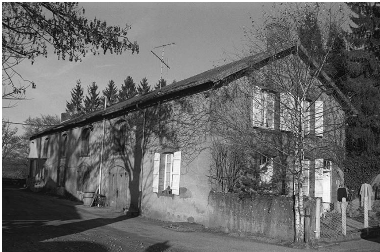
Ecuries et logement, vus depuis le canal.
