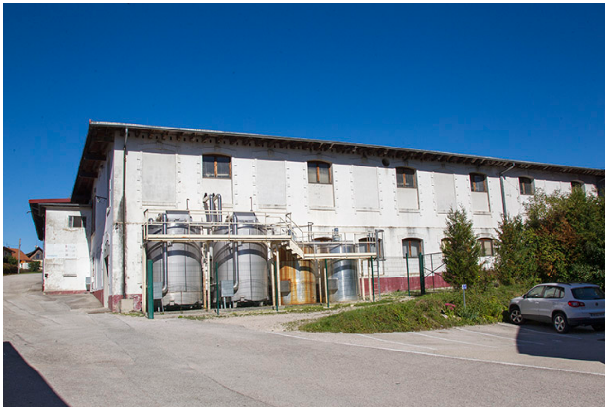
Bâtiments sud : façade latérale gauche.
