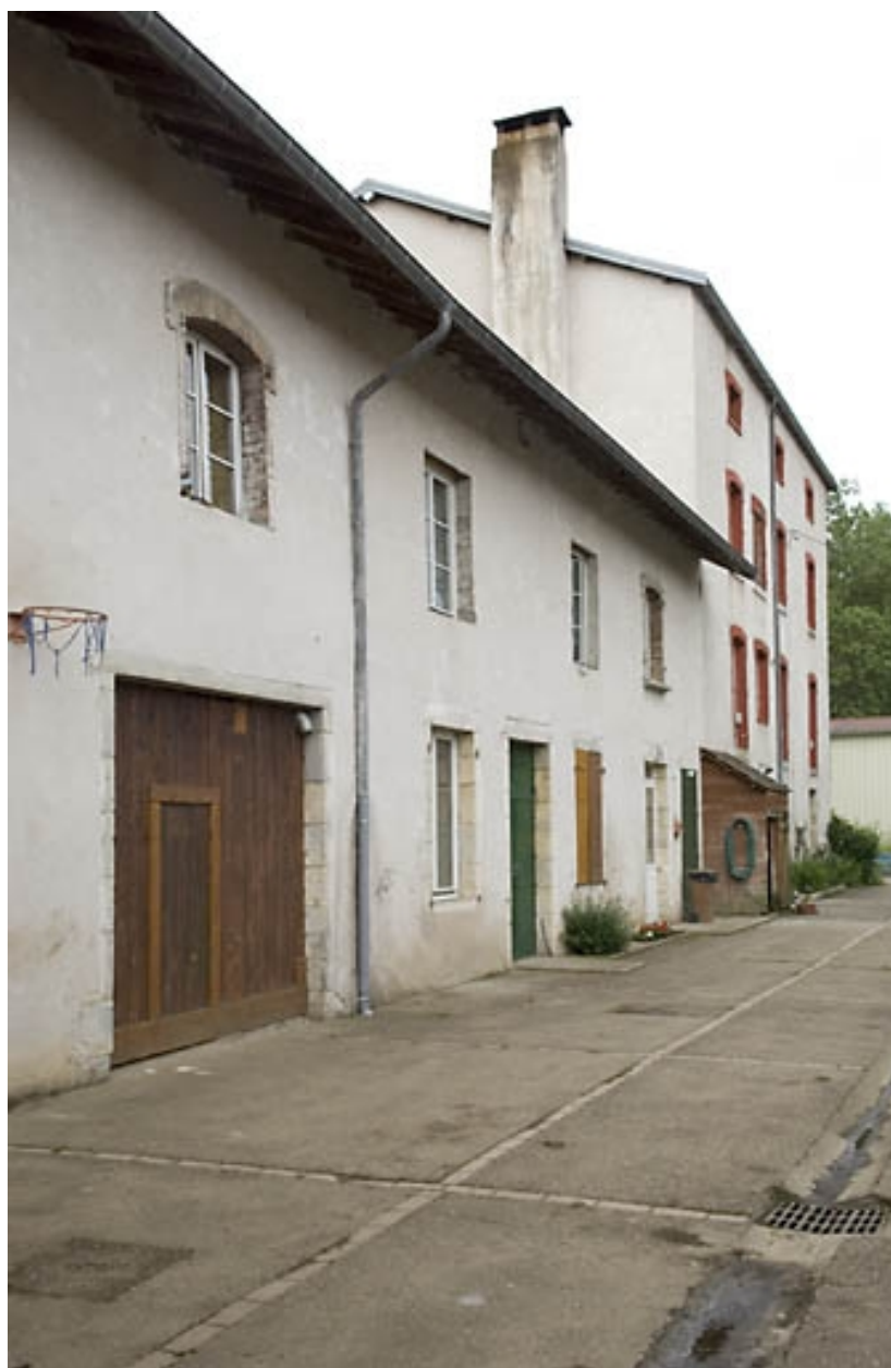
Façade nord vue de trois quarts gauche.
