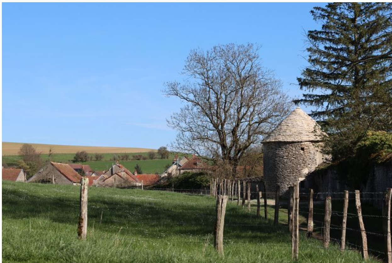
Vue de la tour depuis l'est, après restauration de la toiture en laves.
