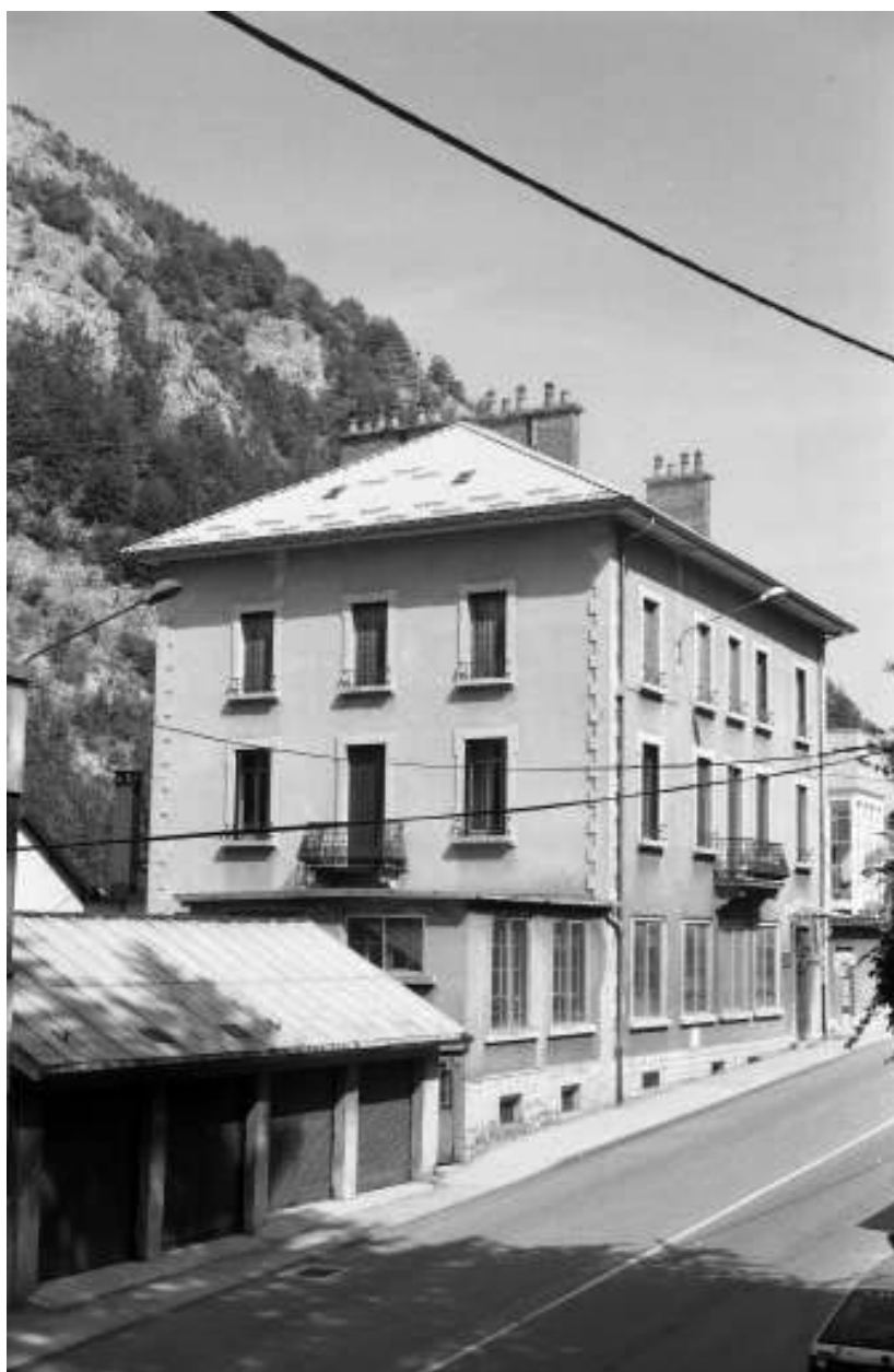
Façades antérieure et latérale gauche.
