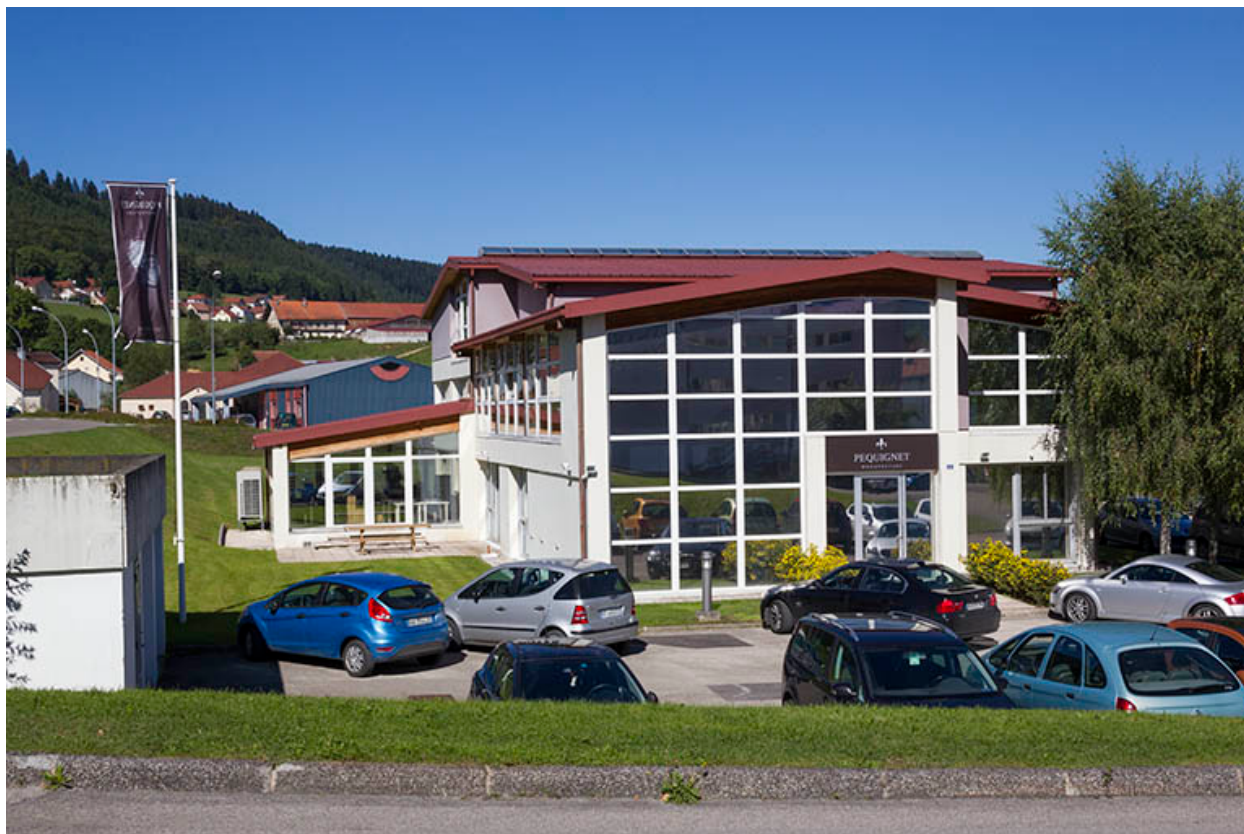
Vue d'ensemble, depuis le sud (façade antérieure).
