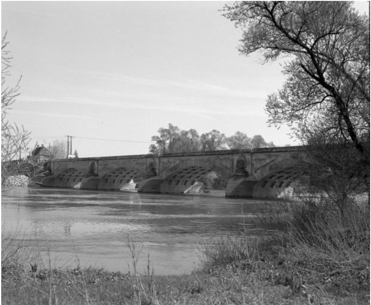
Vue d'ensemble de trois-quarts droit, en aval.
