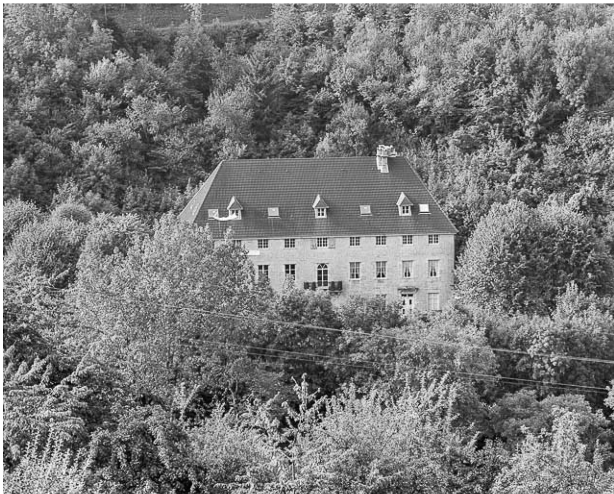
Vue plongeante sur le logement patronal en 1980.
