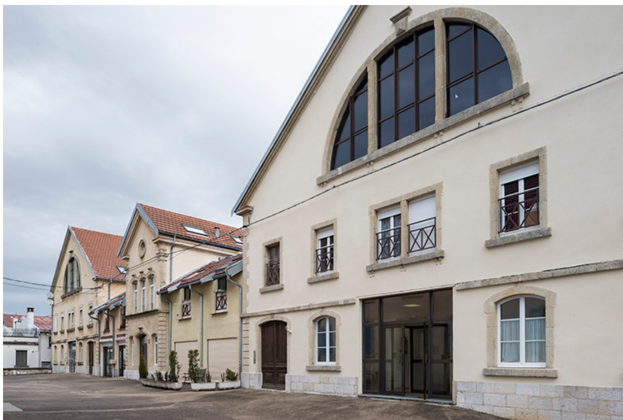
Façade ouest des chais et entrepôts.
