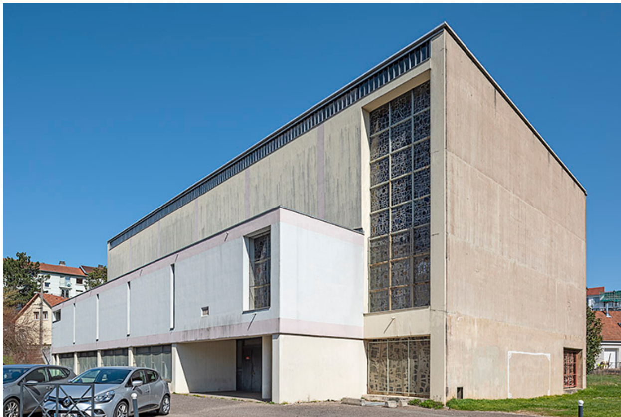
Façades sud-est et sud-ouest. Vue de trois quarts.
