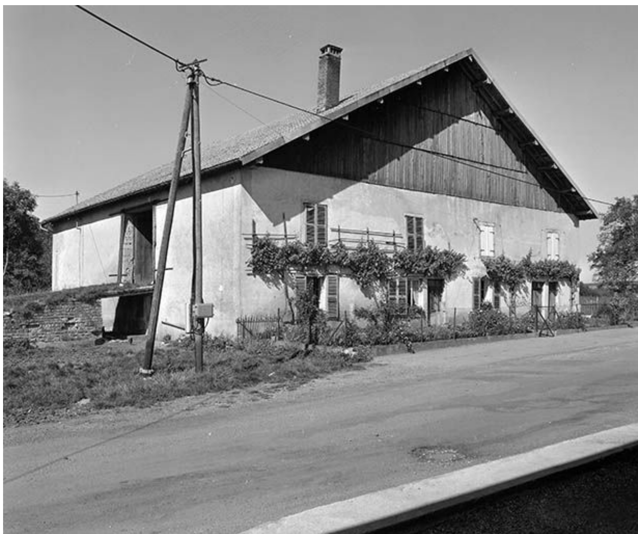
Ferme située chemin du Sel.
