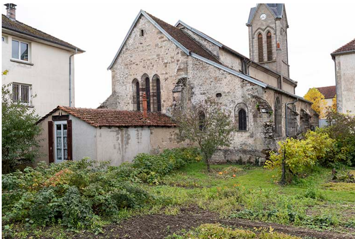
Vue d'ensemble nord-est.
