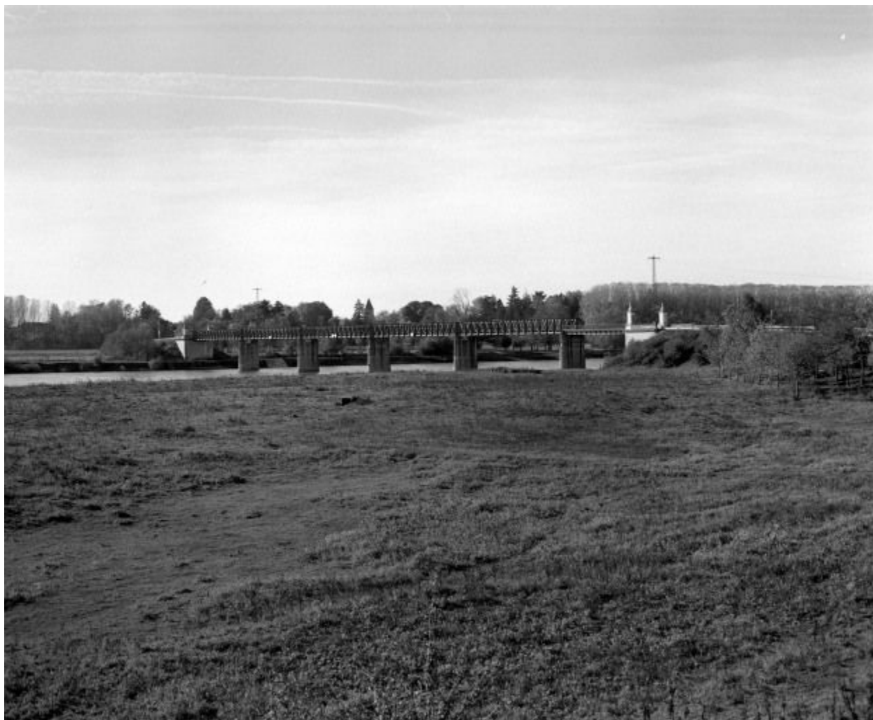
Vue d'ensemble du pont en 1986.
