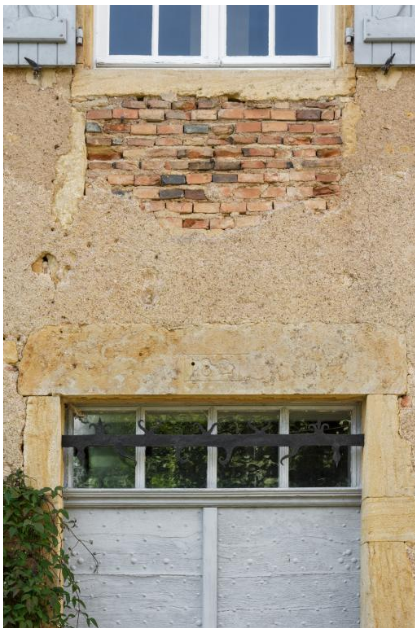
Linteau de la porte de la maison portant la date de 1821 et détail de la maçonnerie en brique sous les assises de fenêtres
