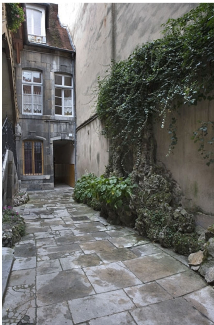
Façade antérieure du logis secondaire sur cour.
